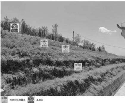
图 11 3 号坡体监测点布设图
