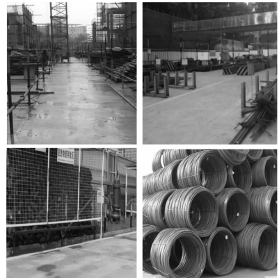
图 4 建筑工地现场图
