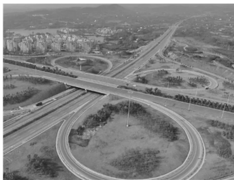
图 8 高速公路实验路段
