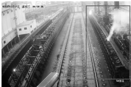
图 3 生产现场的炉顶
