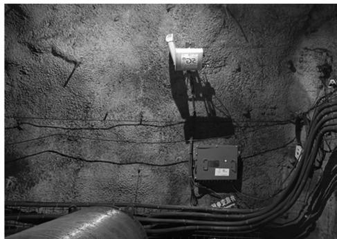
图 5 煤矿井下瓦斯传感器安装实景图
