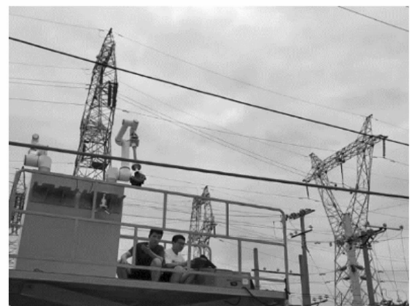
图 8 机器人系统实验现场
