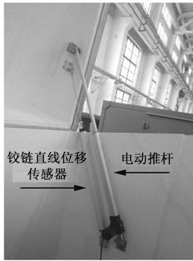
图 1 铰链直线位移传感器和电动推杆的安装
